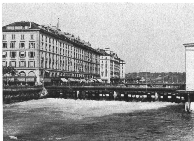
Fig. 2 Barrage à rideaux du Pont de la Machine à Genève, pour le réglage des niveaux du Léman. Vue d'aval. (Photographie A. Kern, Genève, obligeamment remise par le Service des eaux de Genève.)
