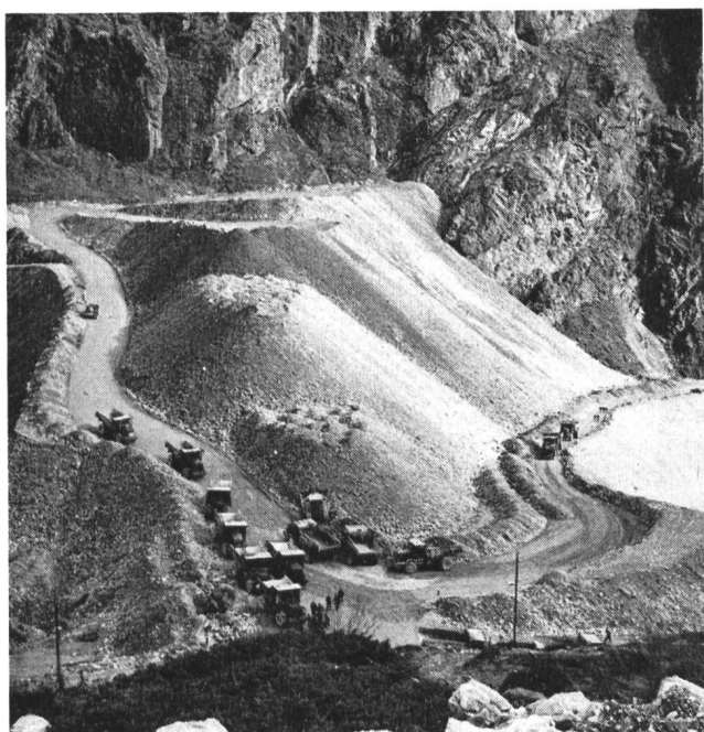
Fig. 8 Dépôt des agrégats à l'aval du barrage (octobre 1954)
