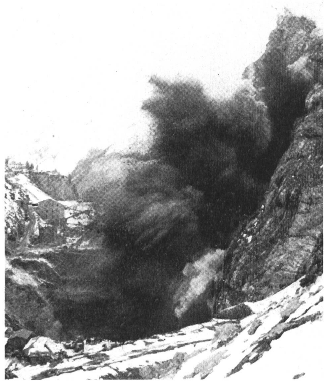
Fig. 5 Grand minage du 11 novembre 1953 sur rive droite; au fond, à gauche, station de lavage-triage
