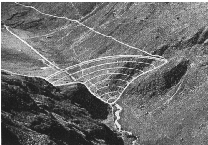
Abb. 4 Staumauerbaustelle vom Unterwasser gesehen (Photo Eidg. Vermessungsamt)
