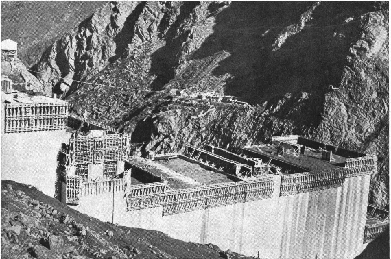
Staumauer Grande Dixence. Betonierung mit Zusatz von BARRA-55-Vinsol
