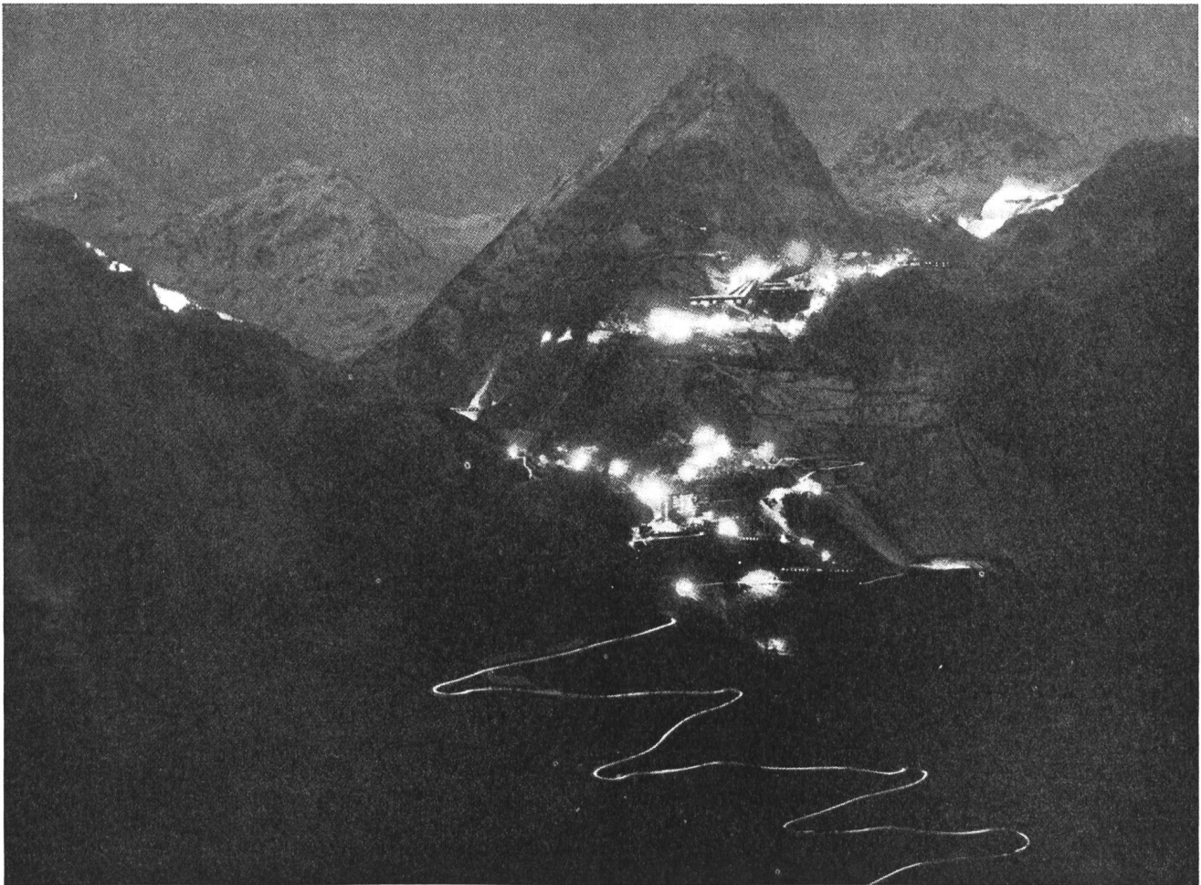
Mondlicht und künstliche Beleuchtung im Hochgebirge Nachtarbeit auf den ausgedehnten Baustellen für die Staumauer Grande Dixence (Photo Frank Gygli, Arbaz/VS)
