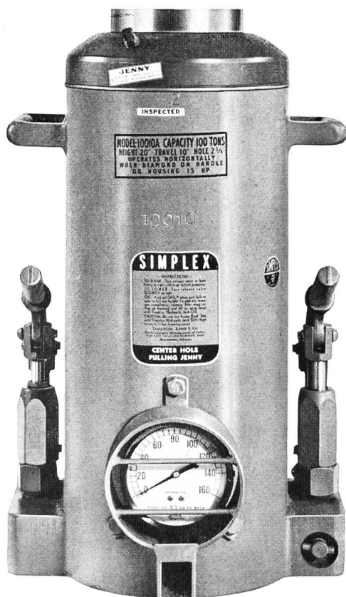
Jenny, 90 t, mit angebauten Hoch- und Niederdruckpumpen und Zentrumloch
