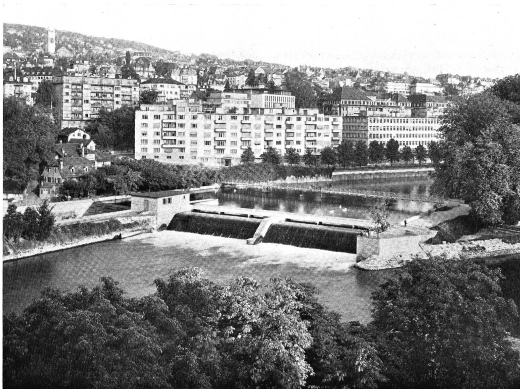
Bild 2 Dachwehr für die Regulierung des Zürichsees
