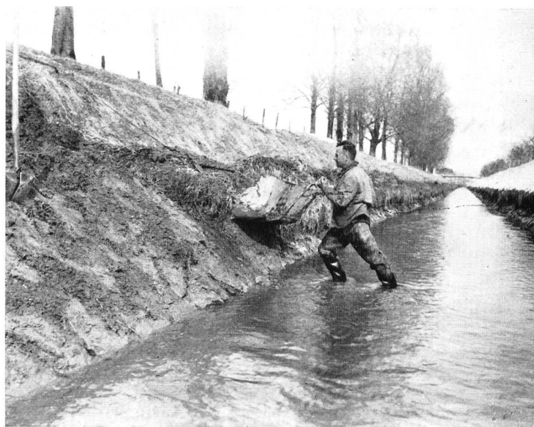
Bild 7 Abtrag verwachsener Böschungen mit Seilzug-Schleppschaufel im Rufibach
