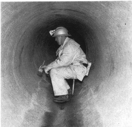
Beschichteter Stollenabschnitt nach dem Auskleiden mit «Cital-Aquapaint»
