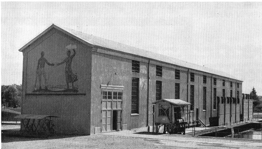
Fig. 2 Ansicht des Maschinenhauses vor der Inangriffnahme der letzten Ausbaustufe. Der Gebäudeteil links der kleinen Treppe ist in der letzten Ausbaustufe abgebrochen worden; an seiner Stelle wurde der neue Rohrturbinentrakt errichtet. Rechts davon befindet sich das heute noch stehende – in der Zwischenzeit jedoch vollständig renovierte – Maschinenhaus mit den drei Vertikalturbinen.
