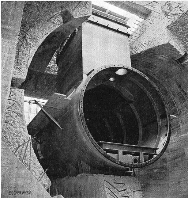
Fig. 8 Setzen des Rohrgehäuses mit Einstiegschacht. Beim grossen Flansch erfolgt der Anschluss des Stützschaufelringes, und an die Stirnfläche des Schachtes wird der Wasserführungssporn geschweisst.
