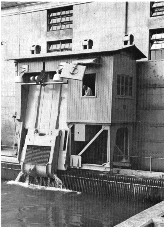
Rechenreinigungsmaschine des KW Rüchlig
