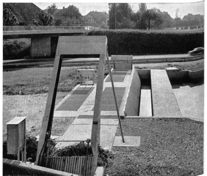
Von uns kürzlich an Autobahnstrecke gelieferte Anlage
