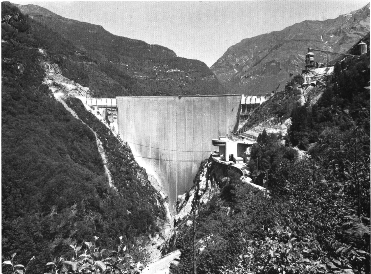
Fig. 18 Barrage, bâtiments extérieurs et sous-station vus de l'aval (mai 1965)
