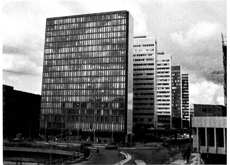
Bild 4 Moderne Hochbauten im Zentrum von Stockholm.
