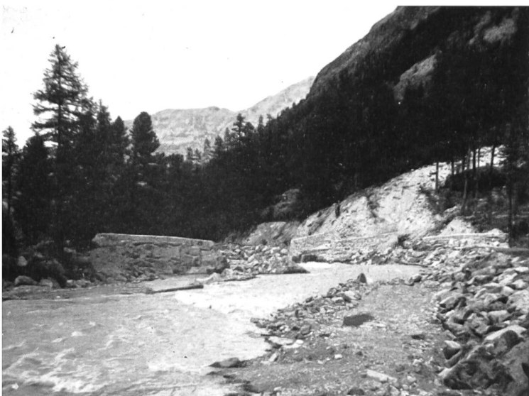
Bild 26 Eine der zahlreichen Schutzsperrn zur Sohlenfixierung des wilden Rosegbaches.
