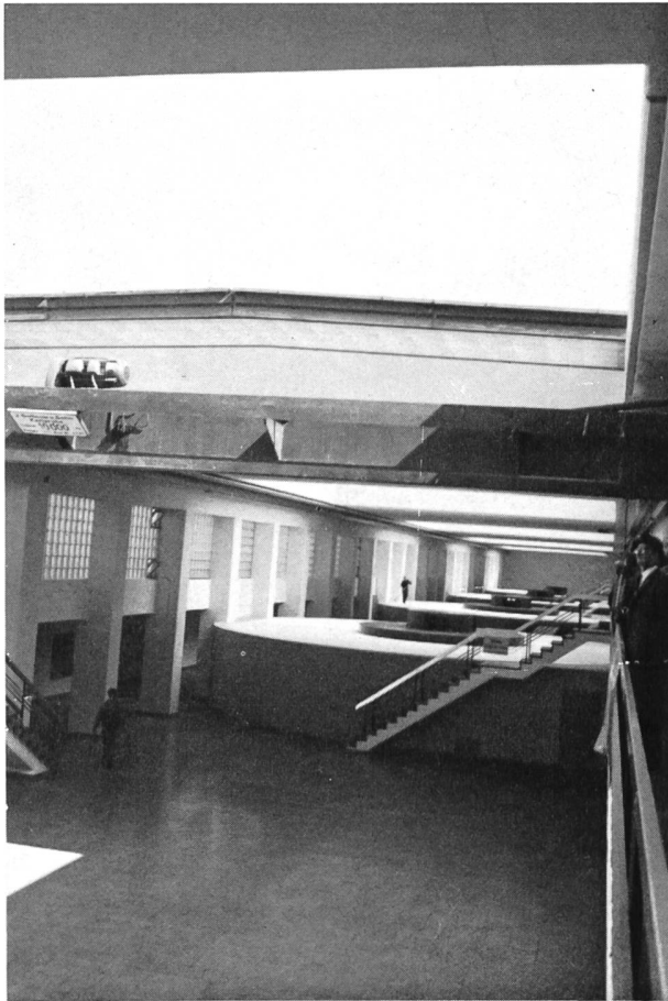
Bild 4 Blick in die Zentrale bei teilweise geöffneter Dachhaut.
