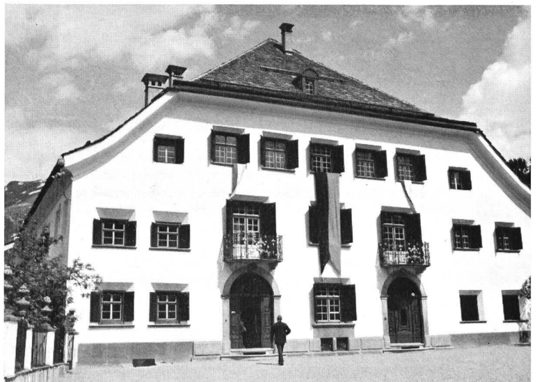
Bild 2 Chesa Planta, typisches Engadiner Patrizierhaus in Samedan, in welchem u.a. die romanische Bibliothek untergebracht ist.
