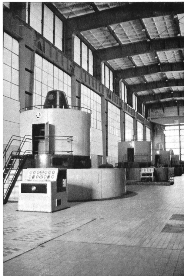
Bild 12 Zentrale Orlik am Talsperrenfuss.
