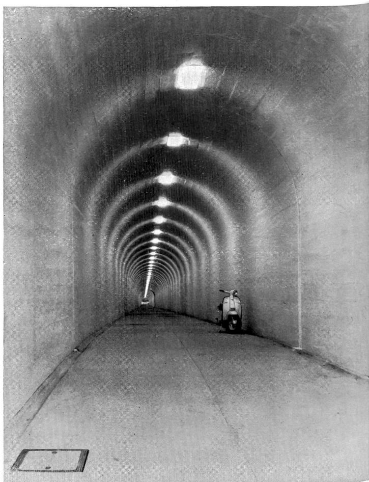
Zugangsstollen zur Kraftwerkzentrale Sedrun GR
