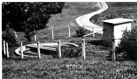
Bild 1 Mechanische Anlage Unterbözberg (Emscherbrunnen)
