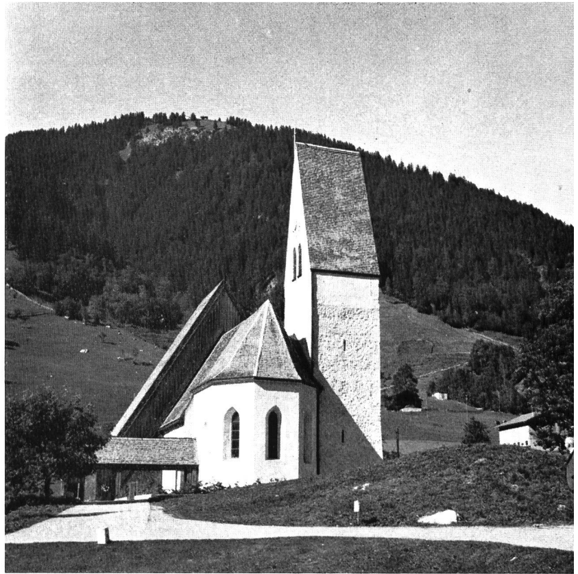
Bild 11 Umgebaute gotische Kirche der Ortschaft Brand in einem südlichen Seitental des Montafon
