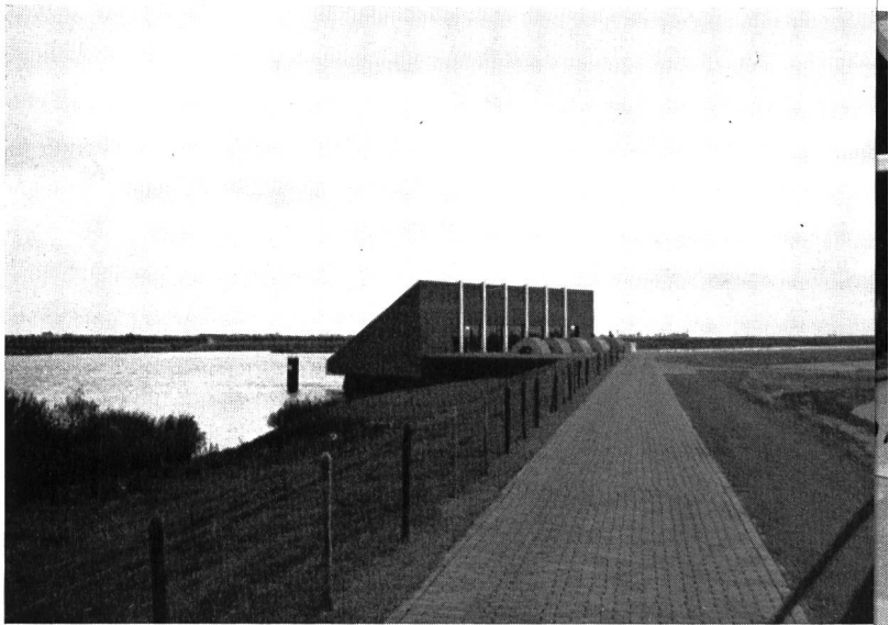
Bild 13 Das schlicht gestaltete Pumpwerk, welches das Wasser vom stark verschmutzten Fluss in das grosse Absetzbecken pumpt
