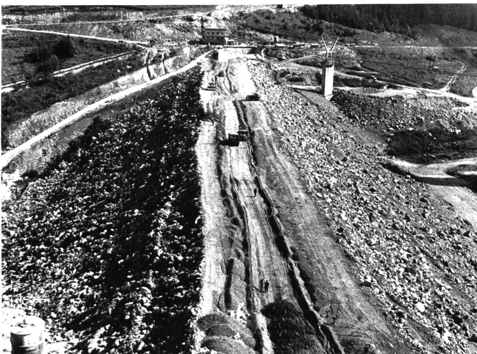
Bild 11 Felsschüttdamm Sance an der Ostranice/ CSSR; Einbau von Kernmaterial und Filter- schichten
