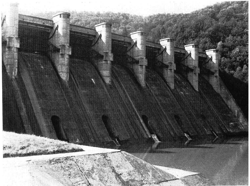
Bild 3 Talsperre Roznow an der Dunajec in Polen; Hochwasserentlastung und Grundablass
