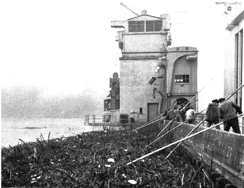
Bild 3 Rechengut am Rheinkraftwerk Reckingen anlässlich des Hochwassers 1968
