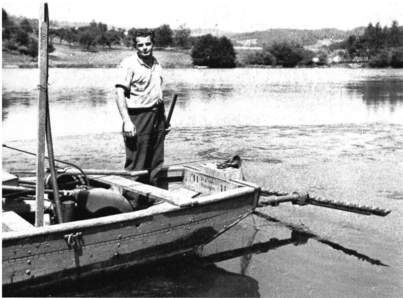
Bild 9 Auf einem Boot montierte Mähmaschine zur Beseitigung von Algen, wie sie bei verschiedenen Werken angewendet wird; Rheinkraftwerk Reckingen 1961
