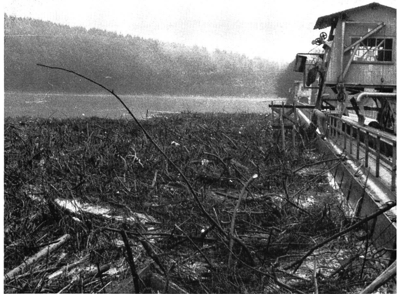
Bild 6 Rechengut beim Rheinkraftwerk Eglisau anlässlich des Hochwassers 1965
