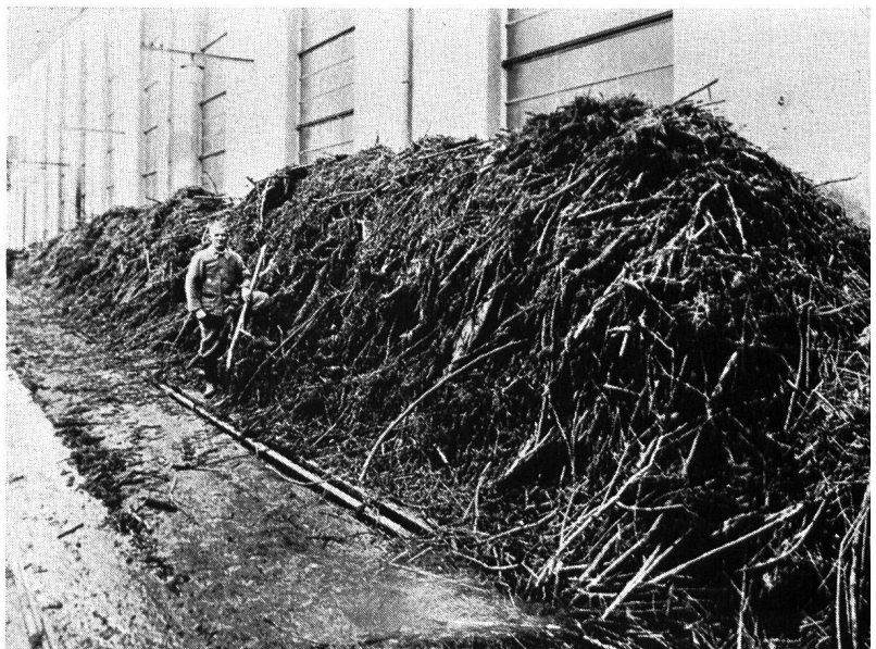
Bild 2 Geschwemmselantrieb des Hochwassers 1953 am Maschinenhaus des Rheinkraftwerkes Albruck-Dogern
