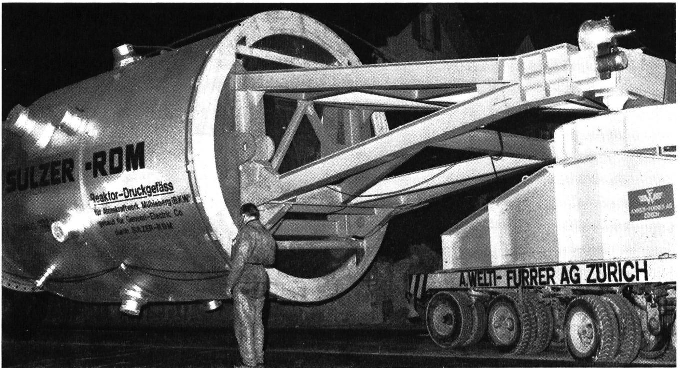
Über 120 Tonnen Gewicht, 8 Meter Länge und mehr als 5 Meter Durchmesser weist dieser Unterteil eines Reaktor-gefäßes auf.
