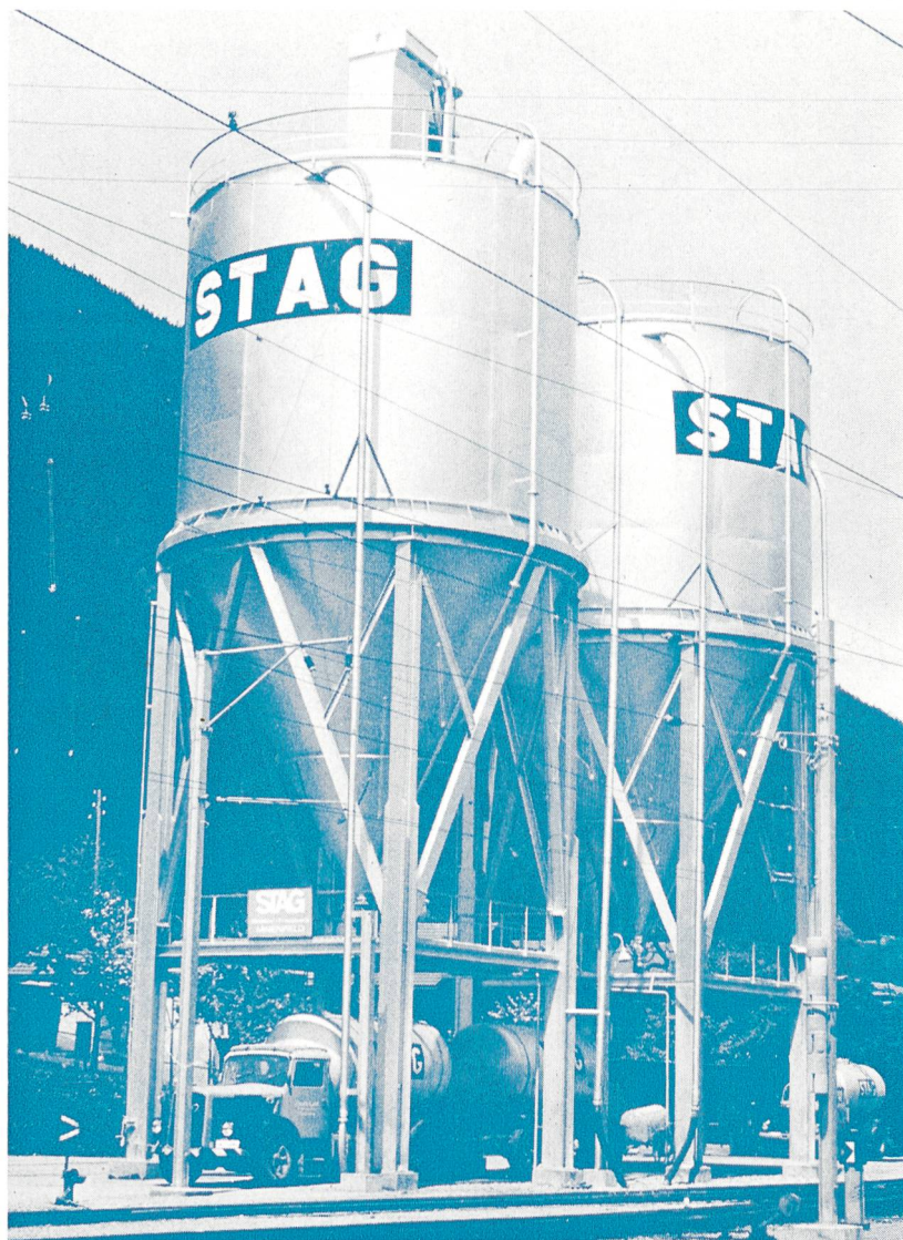
2 Umschlag- und Lagersilos für je 550 Tonnen Silozement mit Brückenwaage auf der Station Disentis
