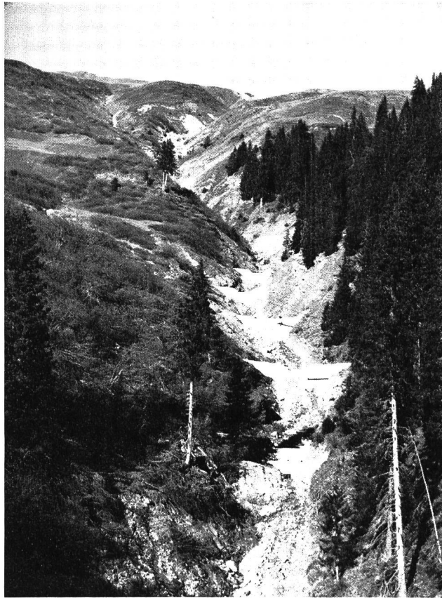
Bild 6 Oberster Teil der Verbauung im Platzertobel, Gemeinde Safien, ausgeführt Sommer 1969
