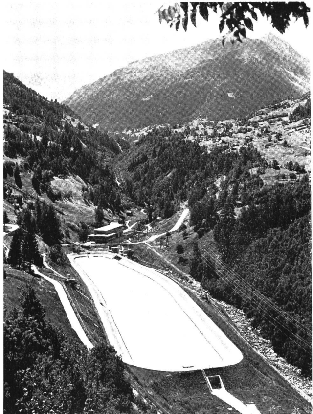
Bild 2 Ausgleichbecken Vissoie, zweite Stufe der Gougra-Kraftwerke; Beckeninhalt 50 000 m 3
