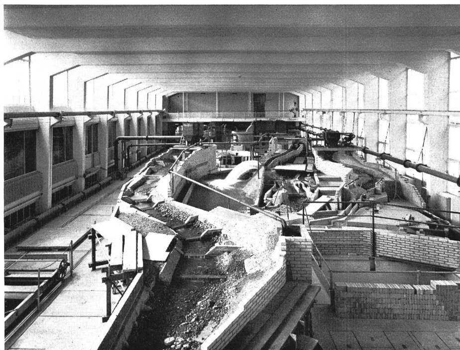
Bild 8 Die neue Versuchshalle im Jahre 1955. Modelle, von links nach rechts: Maira-Korrektion, Castasegna; Hochwasserentlastung Le Mannel, Congo Belge; Wasserfassung Rio Rimac, Peru; Wasserfassung Carnusa, Kraftwerk Zervreila
