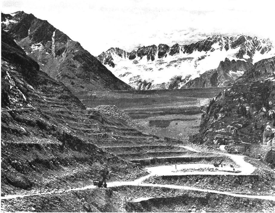
Bild 9 Steindamm Göscheneralp im Gott- hardgebiet mit 155 m Höhe, 540 m Länge und 9,3 Mio m 3 Inhalt der höchste Staudamm der Schweiz
