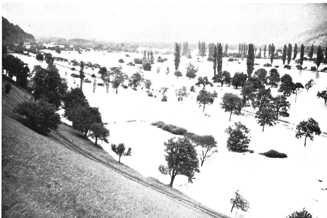
Bild 4 Hochwasser vom 22. August 1954 in der Sarganser Ebene (Photo Rheinbauleitung Rorschach)
