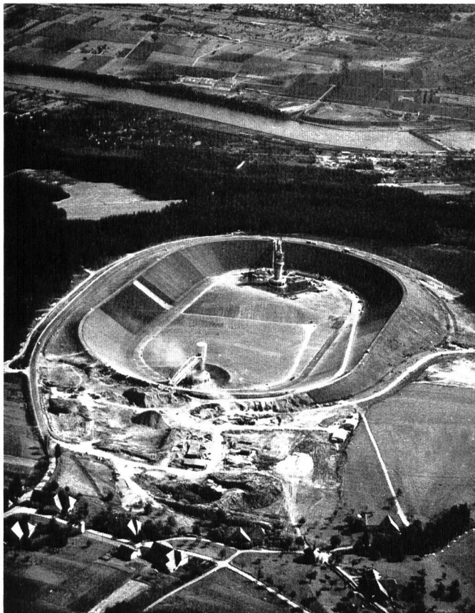
OBERBECKEN DES PUMPSPEICHERWERKES SÄCKINGEN DER SCHLUCHSEE-WERK AKTIENGESELLSCHAFT
