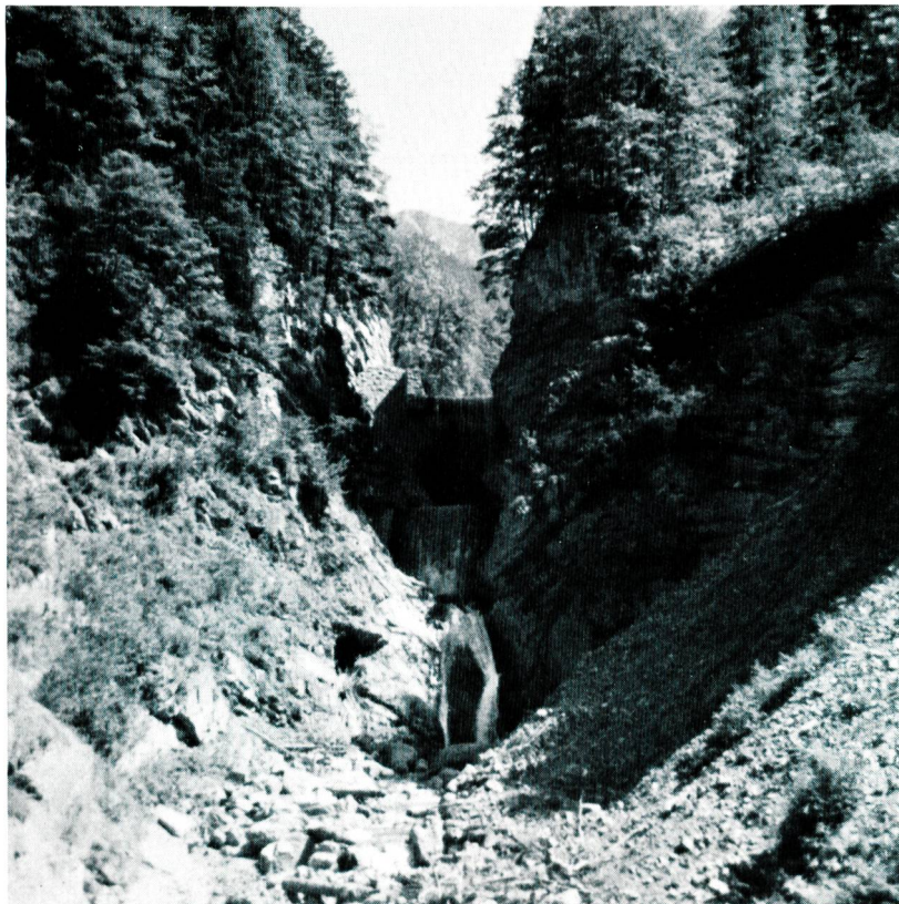
Bild 10 Die unterste, 14,5 m hohe Fixiersperre am Ausgang des Durnageltobels.
