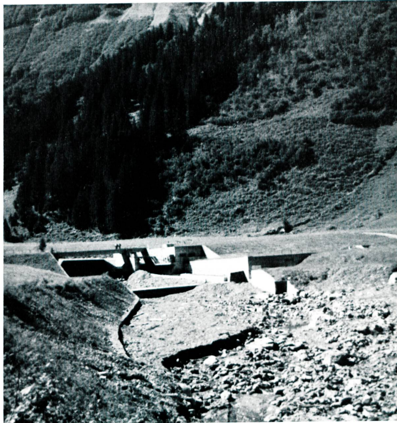
Bild 3 Wasserfassung des Durnagelbaches für die Kraftwerke Linth-Limmern AG.
