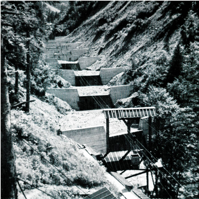
Bild 9 Sperrentreppe im Durnageltobel.
