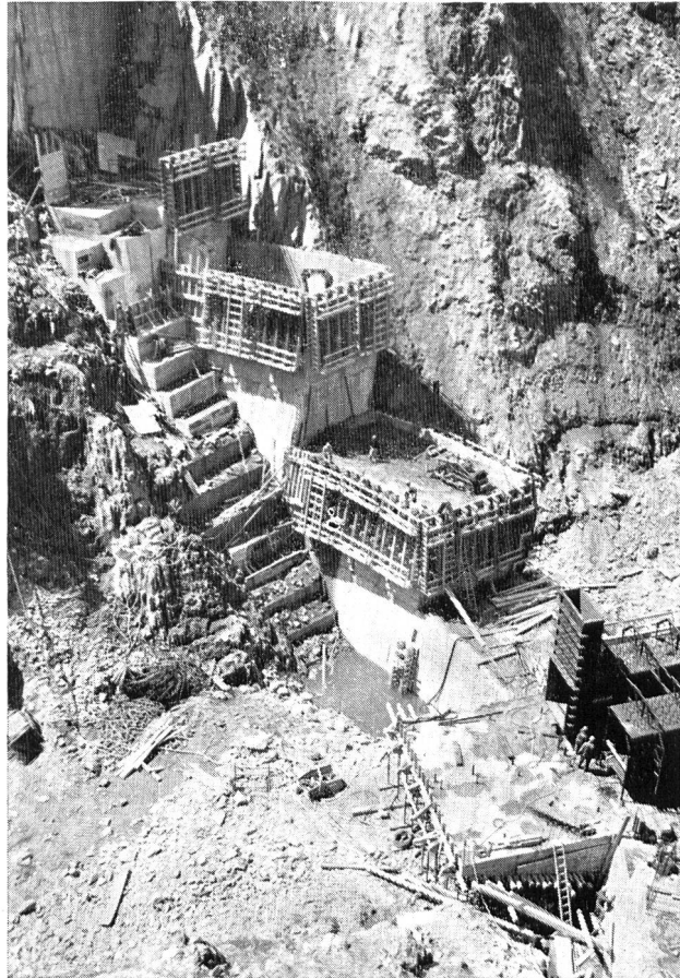
Bild 10 Staumauer Ferden, Bauzustand im Mai 1974.
