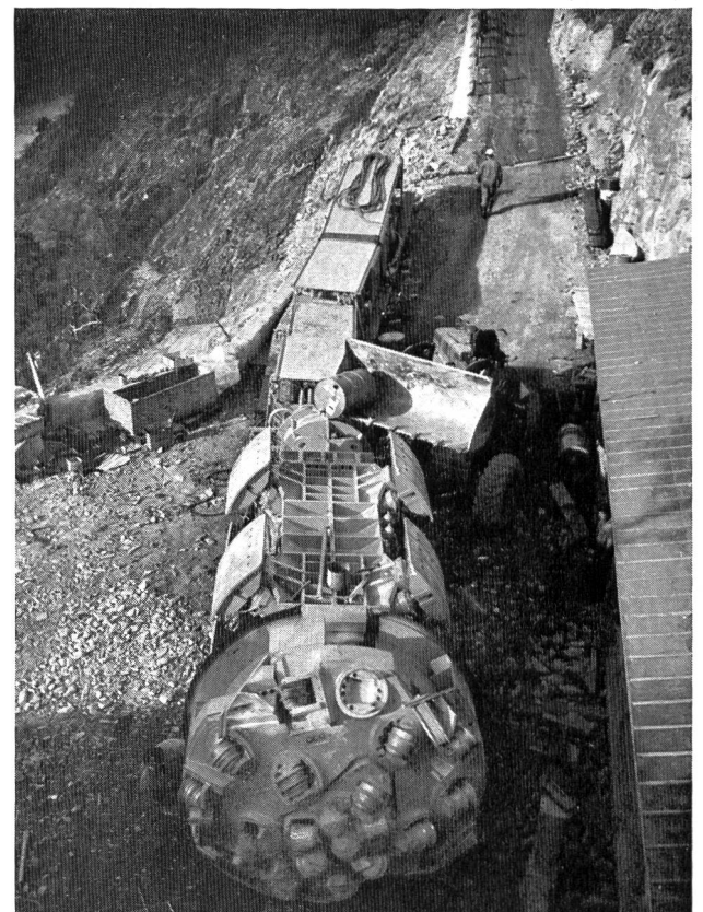
Bild 5 Die Wirth-Bohrmaschine vor dem Portal des Druckstollens Laden (Februar 1973).
