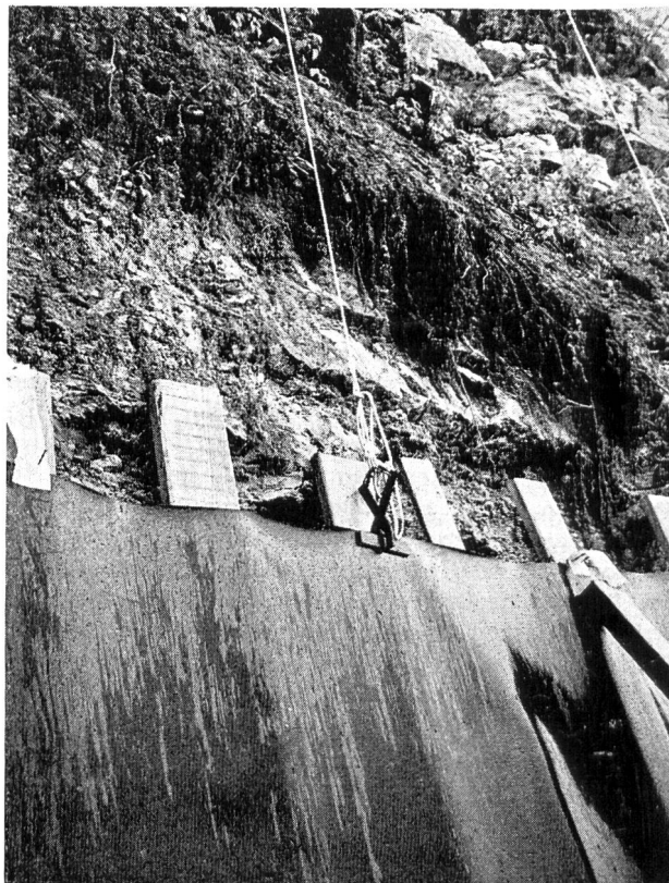
Bild 6 Hochziehen der Folien im Bereich der Felswand.
