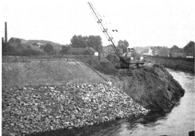
Bild 4. Fertiggestelltes Teilstück und Beginn der Planung des nächsten ausgekolkten Abschnitts.
