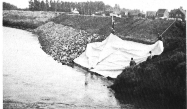
Bild 2. Ausbreiten einer Vliesmatte aus Trevira-spunbond auf dem planierten Dammschnitt.
