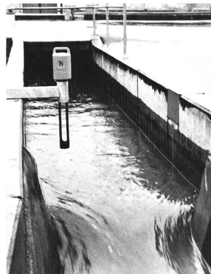
Bild 9. Venturikanal mit eingesetztem Referenz-Echolot.
