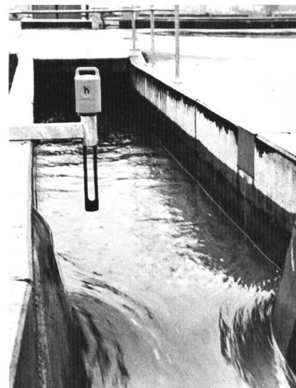
Bild 9. Venturikanal mit eingesetztem Referenz-Echolot.
