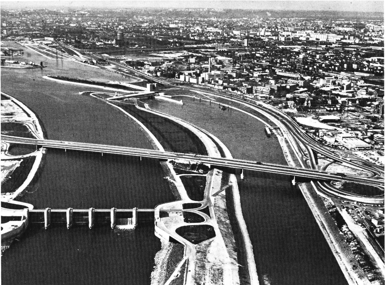
Bild 3. Die wichtigsten Bauwerke der Staustufe Pierre-Bénite. Links unten das Stauwehr, rechts der Unterwasserkanal, in der Mitte die Zentrale mit den Schleusenanlagen, links oben die Hafenanlagen Edouard-Herriot.
