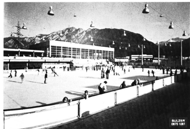
Bild 1. Sportzentrum Obere Au in Chur (CH) mit Kunsteisbahn und Hallenbad im Hintergrund.
