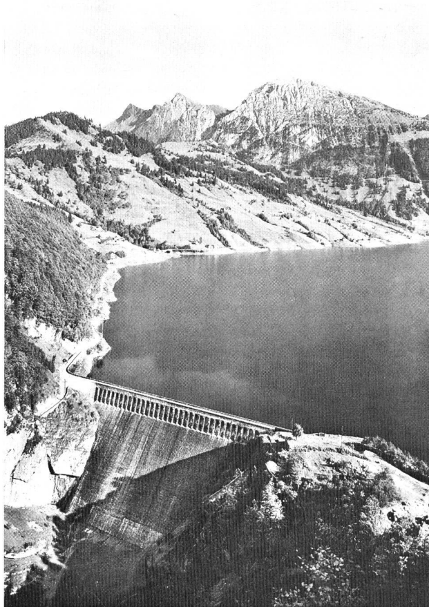
Bild 1. Gewichtsmauer Schräh der Kraftwerke Wägital AG. Die Mauer wurde 1922 bis 1924 gebaut. Im Jahre 1973 wurden die Überwachungseinrichtungen modernisiert und gleichzeitig die Fernübertragung eines Lotmesswertes mit Registrierung im nahegelegenen Dienstgebäude und in der Zentrale Siebnen eingerichtet.
