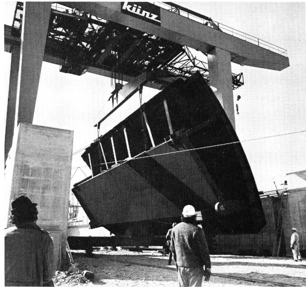
Bild 1. Wehrverschluss eines modernen Donaukraftwerkes. Segment mit Aufsatzklappe, lichte Weite 24 m, Höhe 13,50 m. Der vollständig zusammengebaute Verschluss wird eingebaut.
