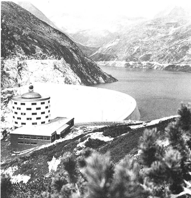
Bild 3. Kraftwerkgruppe Malta der Österreichischen Draukraftwerke/Klagenfurt. Hauptspeicher Kölnbrein.
