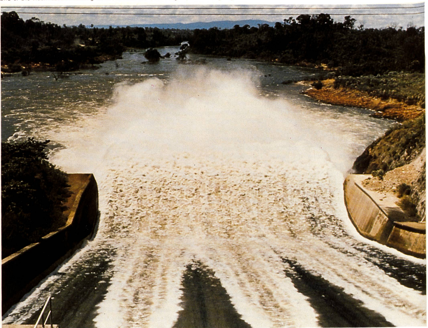
Bild 8. Die Hochwasserentlastung beim Flusskraftwerk Nam Ngum, dem einzigen grösseren Elektrizitätswerk in Laos.
