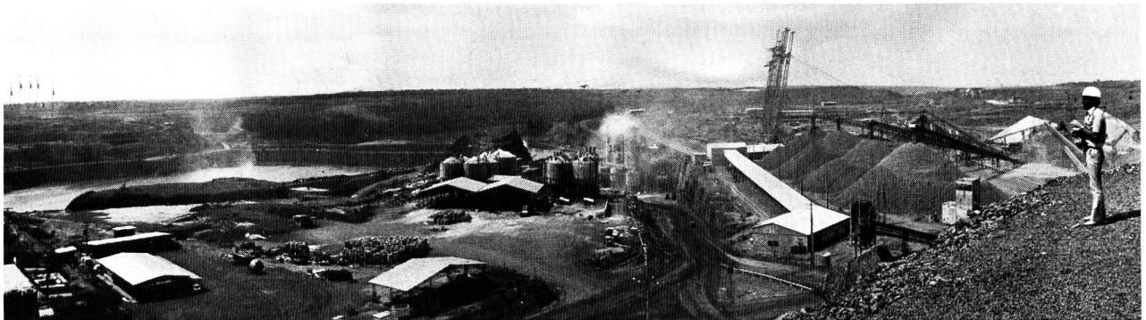
Bild 3. Panorama der Hauptsperstelle Itaipu (v. l. n. r.): rechtsufrige Kabelkrantürme, oberwasserseitiger Fangdamm, Einlauf, Umleitkanal, Zementsilos und Betontürme, Kühlanlage, linksufrige Kabelkrantürme, Aufbereitungsanlage.
