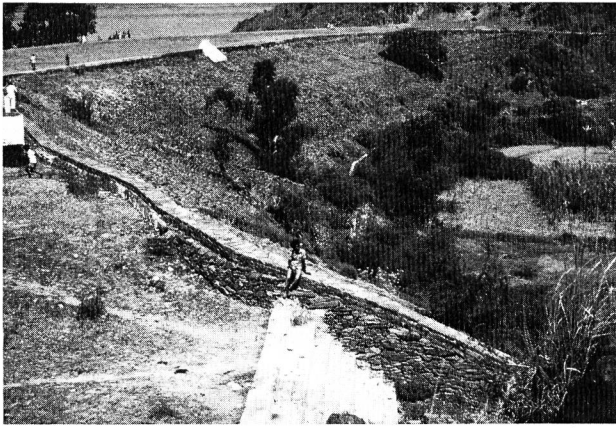
Bild 4. Luftseitige Ansicht des 18 m hohen und 296 m langen Erdammes Cumbum in Andhra Pradesh aus dem 14. Jahrhundert. (Foto: H. Kreuzer, Kirchdorf/AG)
