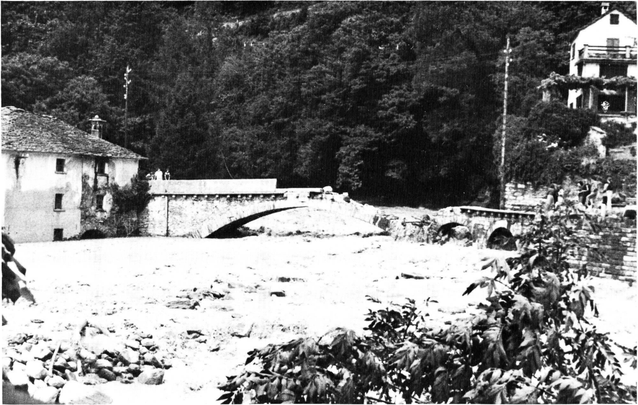
Die durch das Hochwasser vom 7. und 8. August 1978 zerstörte Brücke über die Rovana beim gleichnamigen Weiler. Die Rovana entwässert das Valle di Campo (und das Valle di Bosco), sie fliesst unterhalb Cevio in die Maggia.
