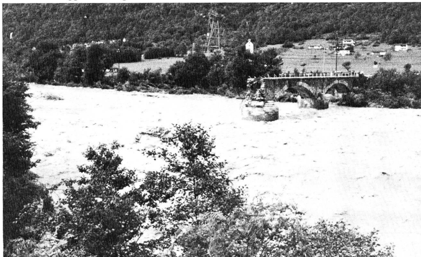
Ponte sulla Maggia ad Aurigeno.
