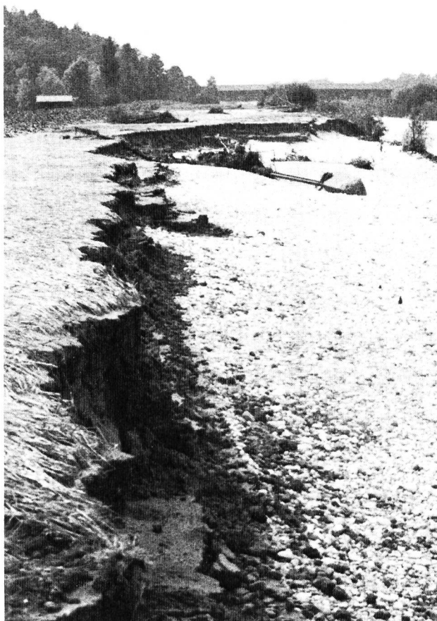
Bild 13. Thur km 22,6, oberhalb der Brücke Eschikofen. Anriss des linken Ufers. 8. August 1978.
