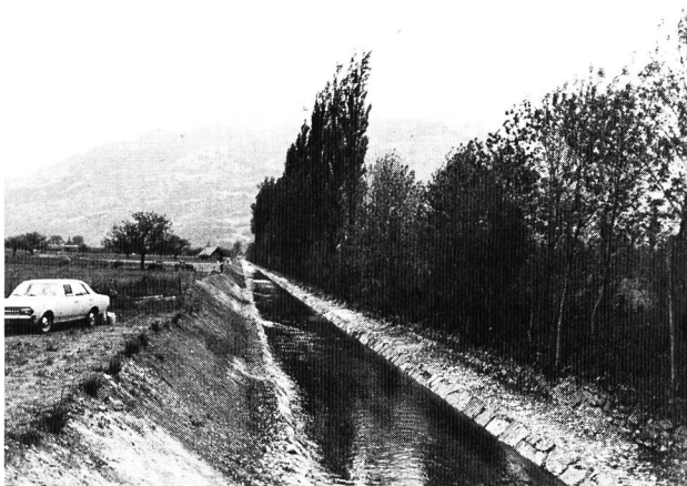
Bild 7. Vertiefter und verbreiteter neuer Saarkanal. Der linksufrige, alte Baumbestand konnte geschont werden. Rechts im Bild erkennt man die kleinen Steine der alten Pflasterung des vor rund 130 Jahren erstellten Kanales und damit die Tiefe der damaligen Grabensohle.
