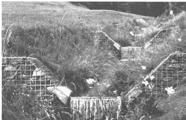
Bild 1: Bachbettverbauung mit Drahtschotterkörben System h+s.
