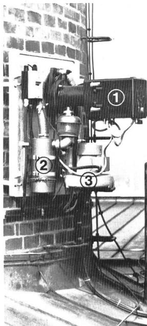
Rauchdichte-Messgerät zur Steuerung einer optimalen Verbrennung und Vermeidung emissionsintensiver Betriebszustände.
