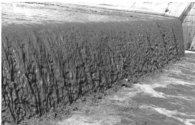
Figura 3. Lago del Rendina. Densità e fluidità del fango possono essere controllate e corrette per avere un alto rendimento senza provocare dannose sedimentazioni a valle della diga. La miscela fangosa qui illustrata si riferisce ai lavori di sfangamento del lago del Rendina ed è costituito da argilla e sabbia. Pur avendo un alto contenuto di materiali solidi, il fango è fluido e scorre facilmente lungo il canale di scarico.
